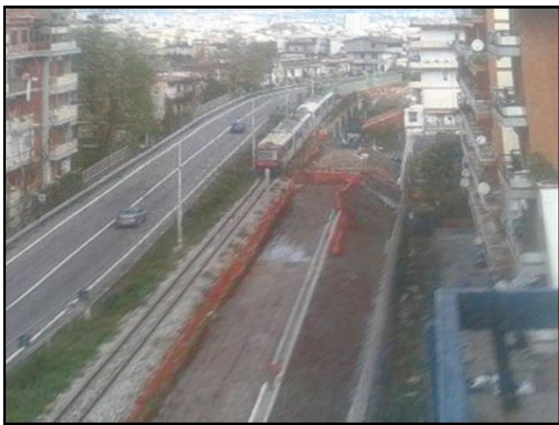
Figura 6.12: Ferrovia Circumvesuviana Raddoppio Tratta Torre Annunziata – Castellammare
