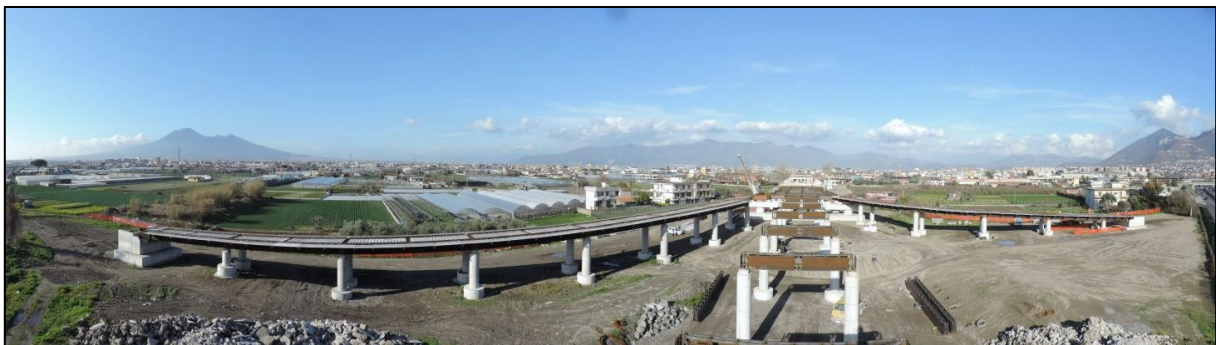
Figura 6.7: SS 268 – Lavori di costruzione del 3° tronco compreso lo svincolo di Angri (GP POR)
