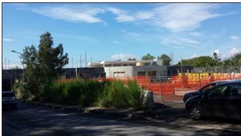
Vista della realizzanda Stazione EAV di Villa Regina - Antiquarium
